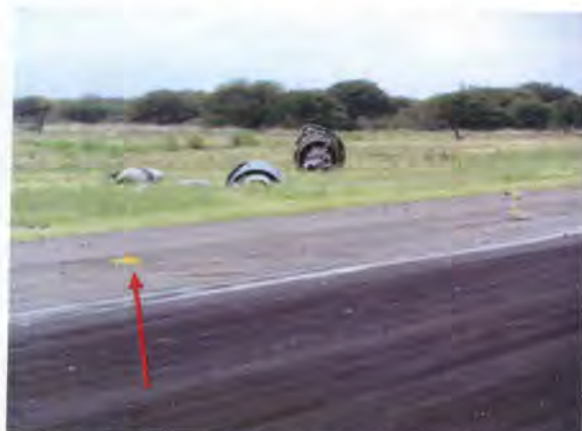
1.4.2, una de las nueve luces de borde de pista dañadas
